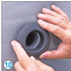
Manschette aufsetzen und eindrücken
